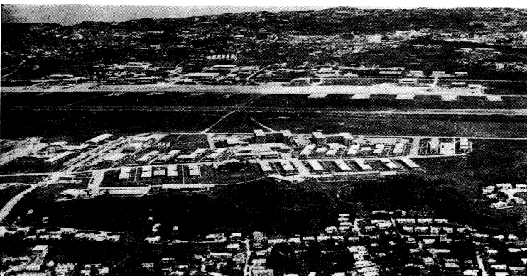
⑫ 普天間飛行場 宜野湾市にある米海兵隊航空基地で、面積150万坪。宜野湾市が住宅地、商工業地造成のため全面解放を要求している。写真一手前は大山の米人向住宅地地域。
